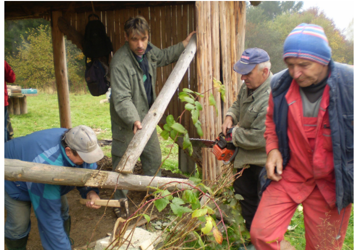
Výmena bočných drevených podpier (zľava Ing. J. Hmirek, J. Urban, J. Ťasnocha, J. Jarina)
